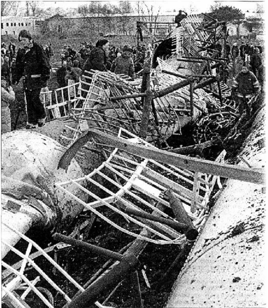
Fallbeispiel Sendemast: das 37 Jahre alte Wahrzeichen im Morast. Der laute Knall der Sprengung wai gestern das Signal für das Ende der Technik Marke Dampfdradio. Fotos: Hans-Henning Hasselberg
